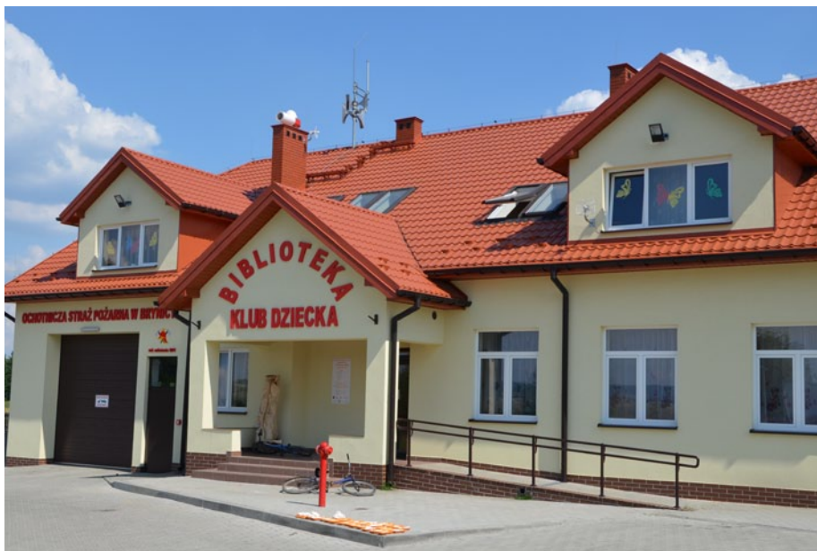
Budowa świetlicy i remizy OSP w Brynicy kosztowała ponad milion złotych, z czego przeszło 400 tysięcy gmina dostała z Unii Europejskiej.
