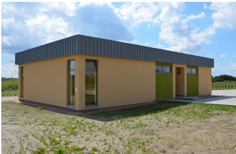
Budowa świetlicy w Wincentowie kosztowała 524 tys. zł. z czego 363 tys. pochodzi z Unii Europejskiej.
